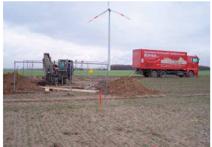
Grundodril-Bohranlage mit Versorgungs-Lkw bei der Pilotbohrung.
